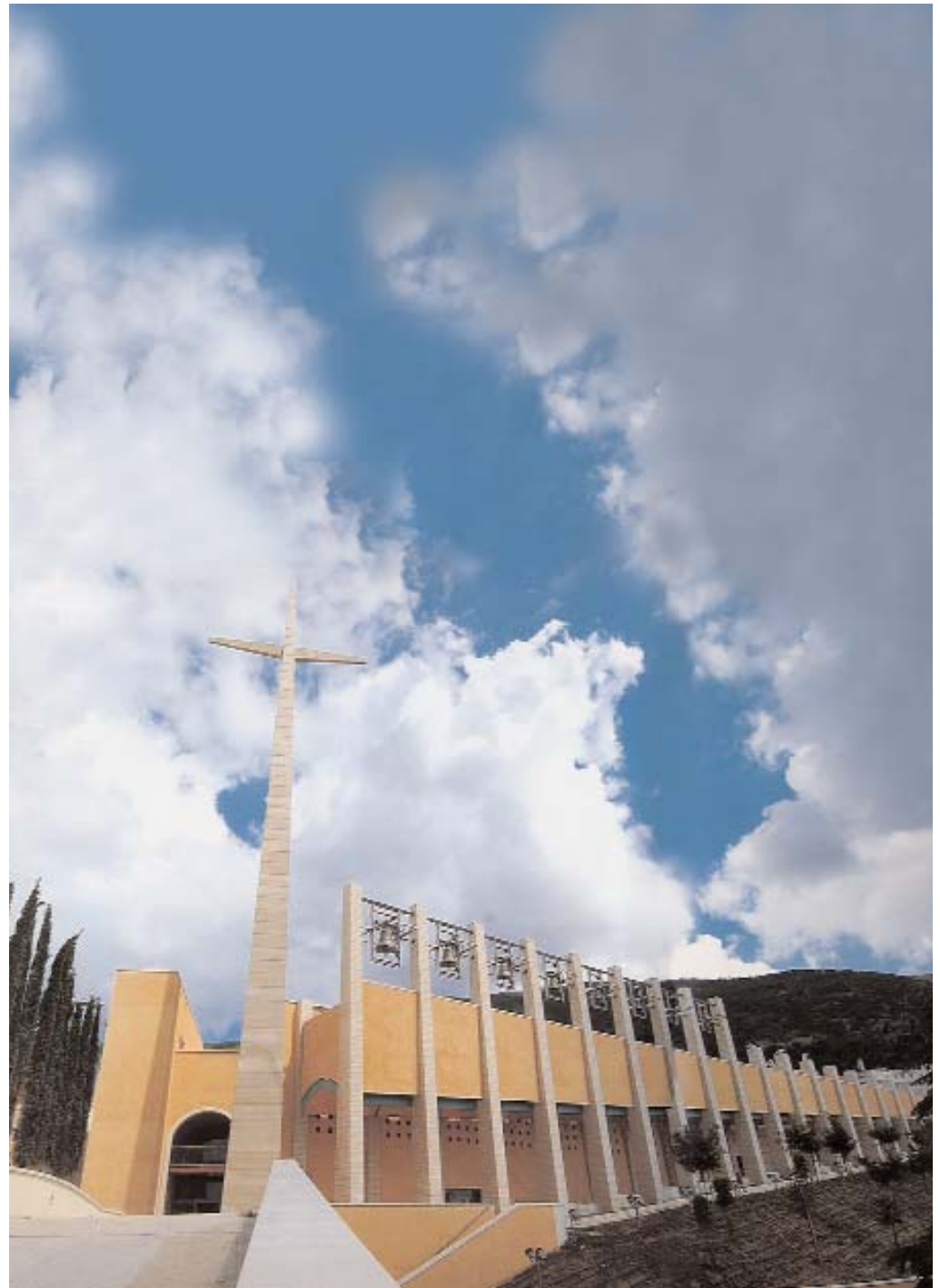
La gran pared del pasillo y el sistema campanario .
