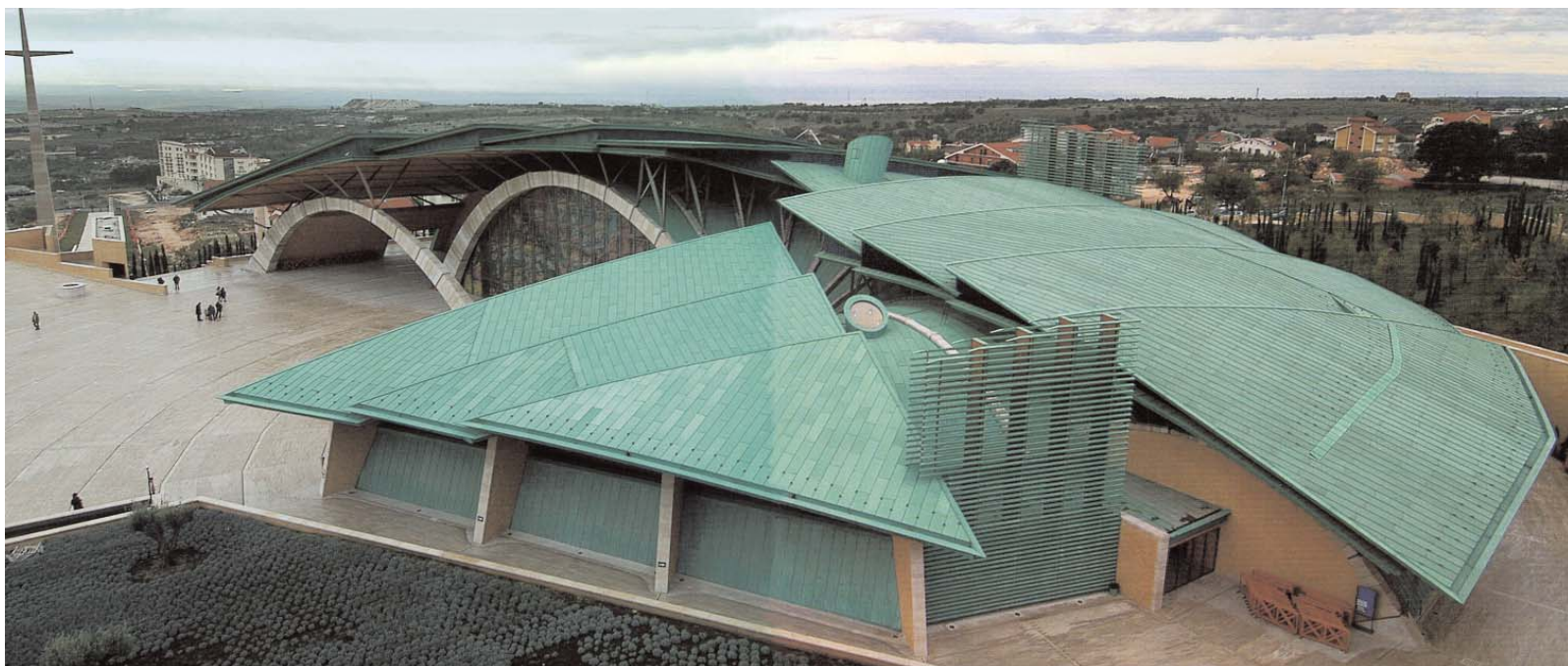
Vista frontal de la “nueva iglesia” dedicada al Santo Padre Pio, en San Giovanni Rotondo (Foggia) – Italia
